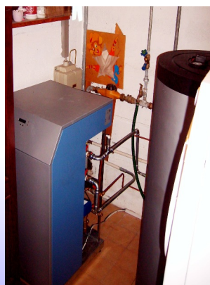
Système solaire ultra compacte
