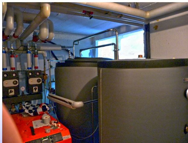
Chaufferie avec 2 ballons solaire ECS inox de 800 litres
