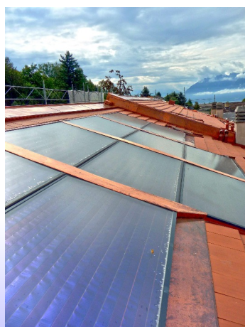
Vue en toiture du champs de capteurs plan vitrés ESE 2.32
