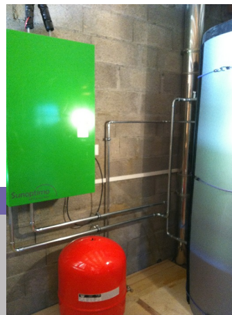
Station solaire et ballon de stockage, avec passage de cheminée à l'arrière
