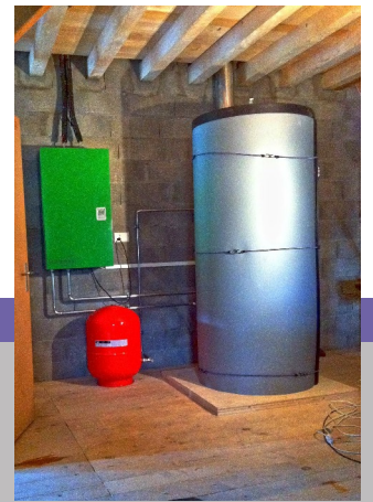
Station solaire et ballon de stockage, avec passage de cheminée à l'arrière
