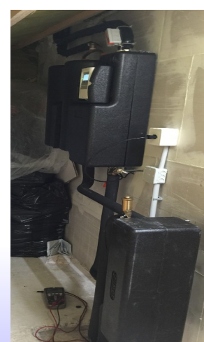
Station solaire avec échangeur à plaque
