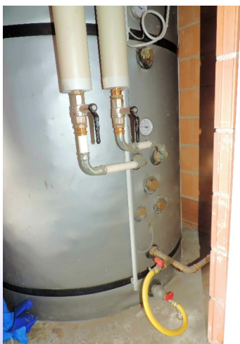
Ballon de stockage à stratification
